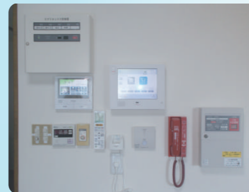
自動火災通報装置
