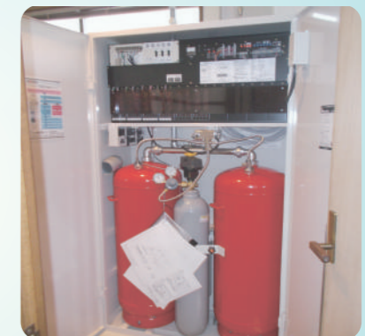
パッケージ型自動消火設備
